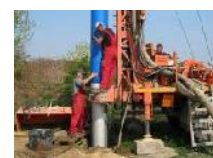
Einbau der Brunnenrohre
