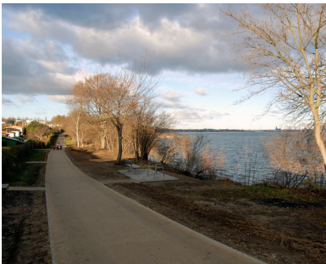
Ostseeküstenradweg bei Devin unmittelbar nach der Herstellung Dezember 2013
