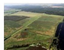
Aktueller Zustand Polder Pinnow
