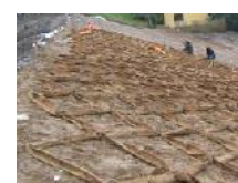
Flechtwerk für Oberbodeneinbau (Geozellen)
