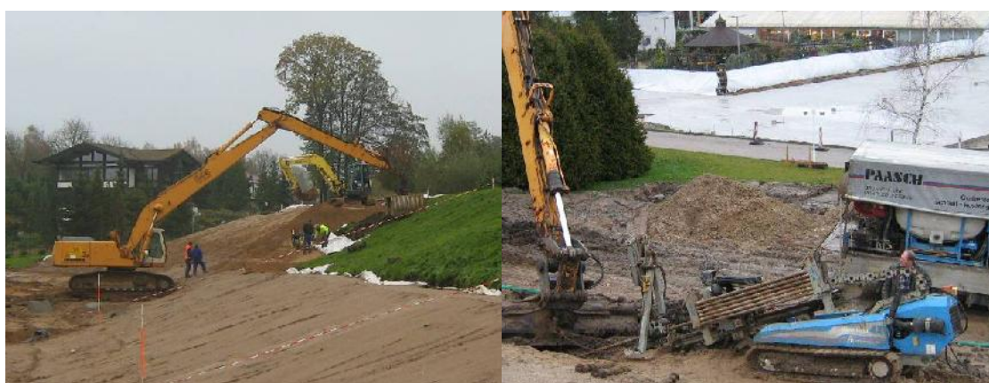
Lagenweiser Neuaufbau der luftseitigen Dammböschung
