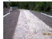
Fuß- und Radweg über den Au Graben
