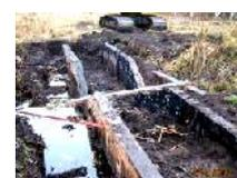
Staubauwerk im Bauzustand
