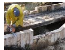
Grabenverbau in Arbeit
