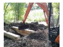
Grabenverbau (Holzspundwand)
