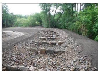
Fischaufstiegsanlage (Bauphase)
