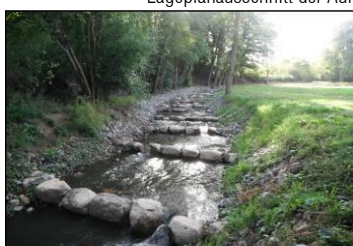
Fischaufstiegsanlage im Betrieb
